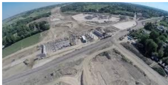
Droga ekspresowa S-8 Wyszków – węzeł Poręba
