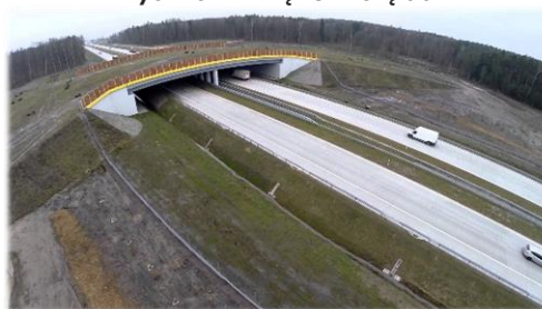
Droga ekspresowa S-8 Wyszków – węzeł Poręba
